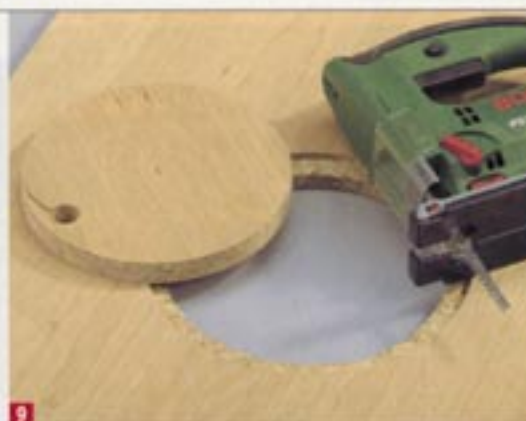
9 Loch für das Sägeblatt bohren und die Lautsprecheröffnung mit der Stichsäge am inneren Rand der Nut entlang ausschneiden
