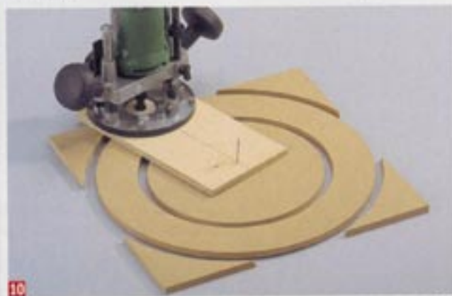
10 MDF- oder Spanplattenringe für die Bespannung ebenfalls mit der Oberfräse ausschneiden; in mehreren Gängen, um den Fräser nicht zu überlasten
